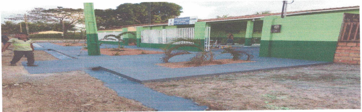
Posto de Nova Mocajuba – Serviços executados (área interna do posto).
